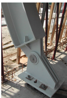
Figura 1 Costruzioni edili in acciaio: cerniera.
