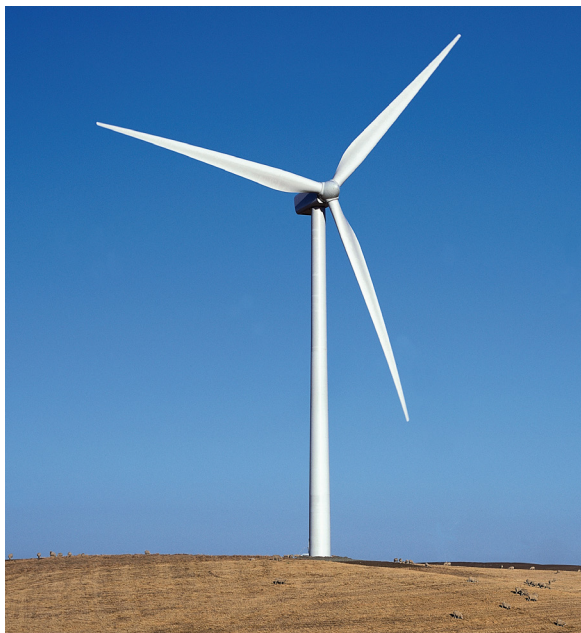
Fig. 11.16 - Un generatore eolico può arrivare anche a potenze molto elevate: un aerogeneratore ad asse orizzontale nella base area militare di Warren (Wyoming) in grado di erogare fino a 2 MW di potenza elettrica.
