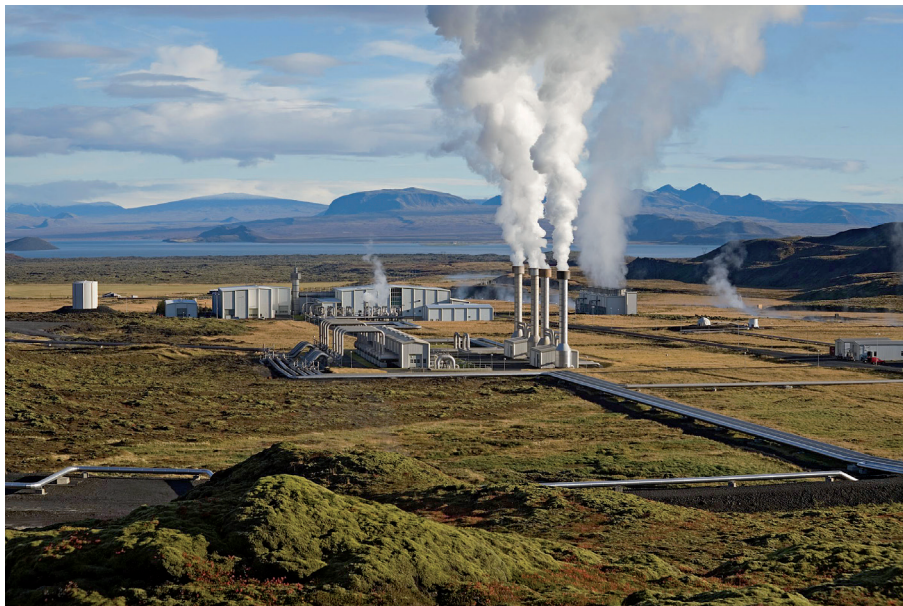
Fig. 11.18-b - La centrale elettrica geotermica di Nesjavellir in Islanda.
