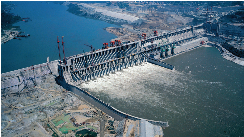
Fig. 11.3 - L'impianto idroelettrico sul fiume Yangtze in Cina con 26 unità installate, delle quali 6 turbine Francis e 6 generatori elettrici che sono stati forniti dal consorzio Voith Siemens Hydro-Power Generation e General Electric Hydro. La potenza complessiva delle 26 unità, pari a 18.200 MW, equivale a quella prodotta da 15 centrali nucleari oppure 22 centrali a carbone.
