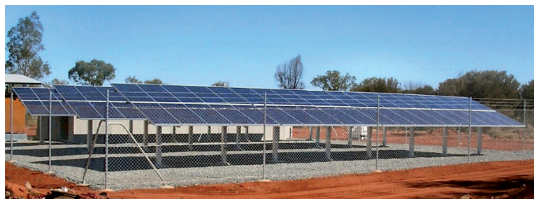
Fig. 11.13 - Nel deserto australiano, diverse comunità di aborigeni usano, per la generazione di energia elettrica, i pannelli fotovoltaici anziché i motori Diesel.
