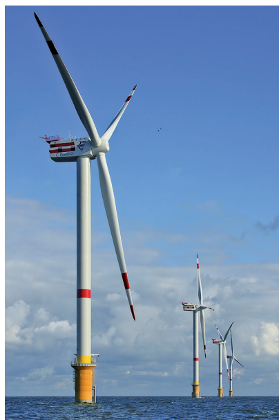
Fig. 11.15 - Quattro generatori eolici a Thornton, 28 km al largo della costa belga sul Mare del Nord; lunghezza della pala = 61,5 m, diametro del rotore = 126 m, potenza = 5 MW (REpower).
