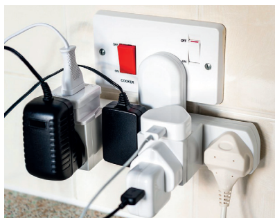
Fig. 24 - Esempio di sovraccarico di prese elettriche, da evitare.
