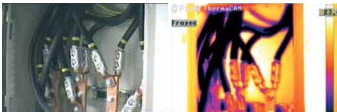
*Questa immagine termica appare molto strana, se non si conoscono le condizioni in cui è stata acquisita. I cavi non sono affatto sovraccarichi. Si trovano in una stanza calda e la loro superficie metallica non ossidata riflette il calore della stanza.*
