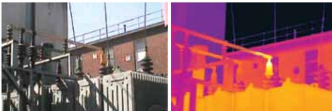
*Un'immagine completa di una sottostazione può mostrare rapidamente aree con presenza di connessioni ad alta resistenza indesiderate. Nessun'altra tecnologia è così efficiente per l'ispezione elettrica quanto la termografia ad infrarossi.*
