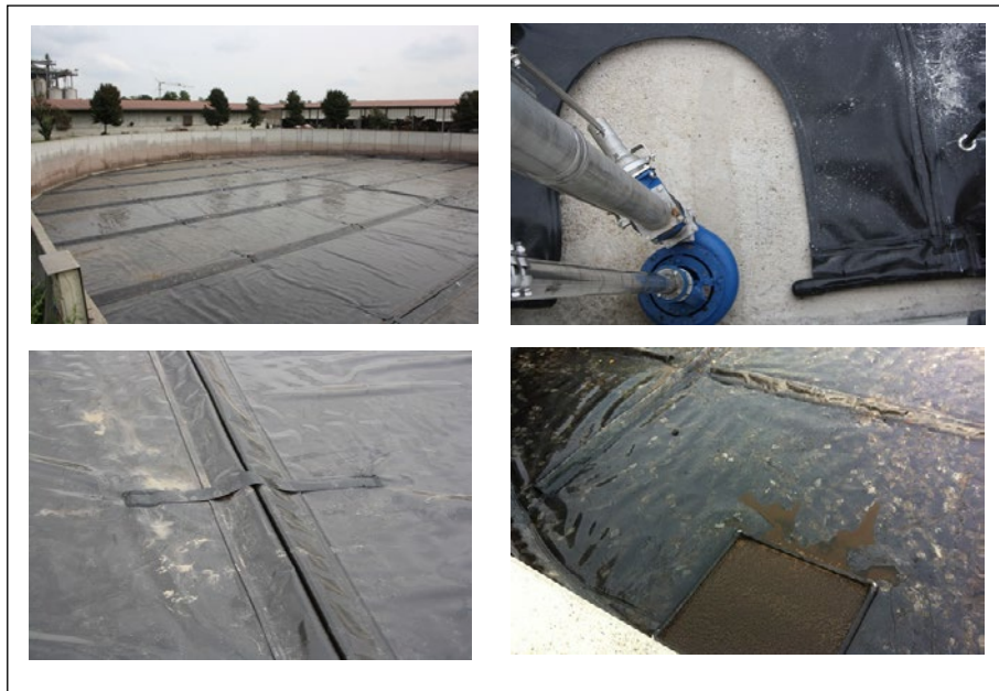
Figura 3 – Copertura flottante per vasche di stoccaggio Acquafert (Guidetti, 2015).
