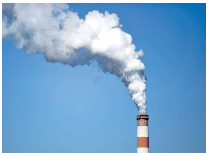
Figura 2 Gli impianti di riscaldamento emettono grandi quantità di polveri sottili.
