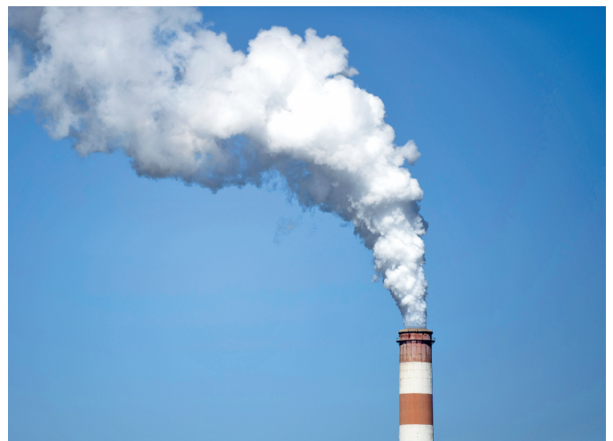
Figura 2 Gli impianti di riscaldamento emettono grandi quantità di polveri sottili.
