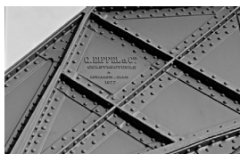
Lamiere chiodate (ponte Eiffel, Oporto).
